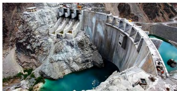
شکل ۱- سد بتنی دو قوسی «شهریار» در شهرستان میانه [۵]
