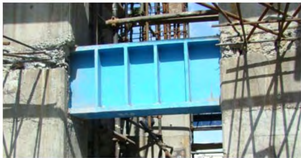
▲ شکل ۵. تیر همبند فولادی [۶]
